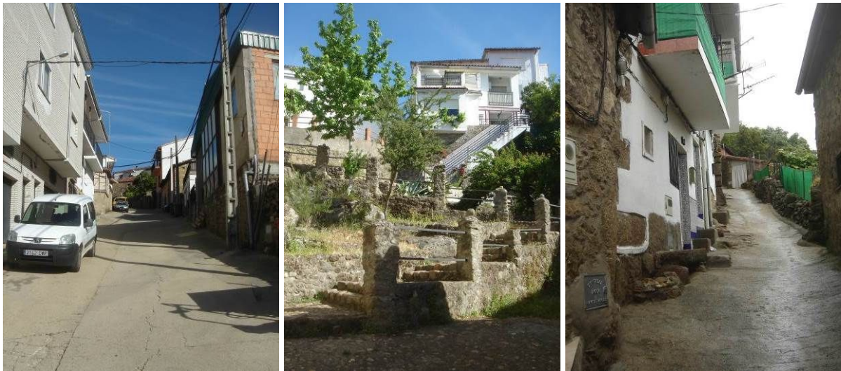
Calles con fuertes pendientes. Solución de desniveles con escaleras. Accesos a viviendas en calle con fuerte pendiente. Dificultad de uso para personas con movilidad reducida por razón de la edad o de circunstancias físicas específicas.
